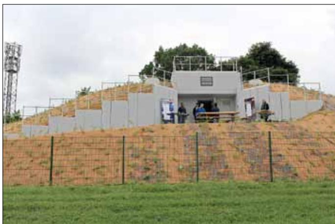
*Eingang zum Bauwerk, umgeben von einer massiven Erdanfüllung*
