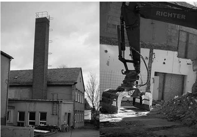
Für den Außenstehenden war der Abbruch des markanten Schornsteins der Schule gut zu verfolgen. Auch der Verbindungsbau, zwischen dem Bau von 1930 und den 2 Anbauten von 1962 und 1982, wurde komplett abgebrochen.
