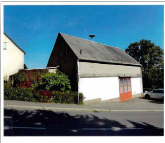
Alte Feuerwehr Pfaffenhain, Gewerbeobjekt 09387 Jahnsdorf OT Pfaffenhain Flurstück Nr. 47/2
