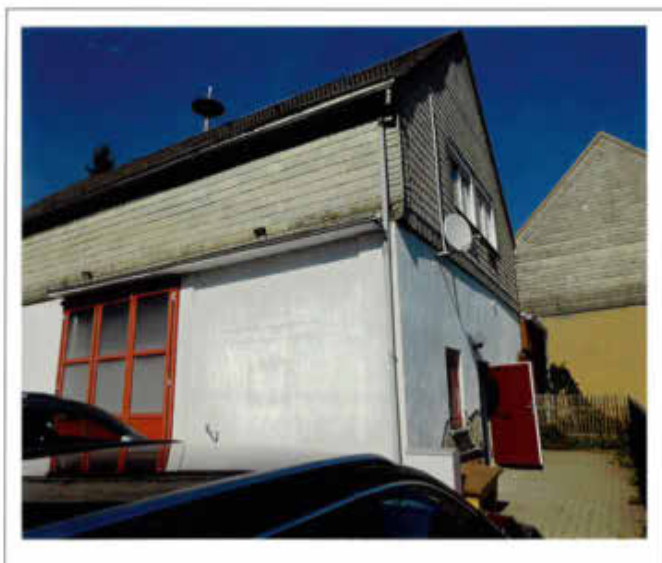
zweigeschossiges Objekt mit Satteldach Ansicht Süd
