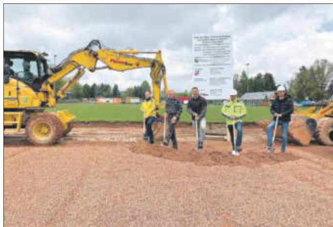
Beim symbolischen 1. Spatenstich v. l.: Erik Weidauer (SV Leukersdorf), Detelf Voigt, Albrecht Spindler, Falk Ehmer (Planer), Ralph Schremmer (Phönix Bau)
