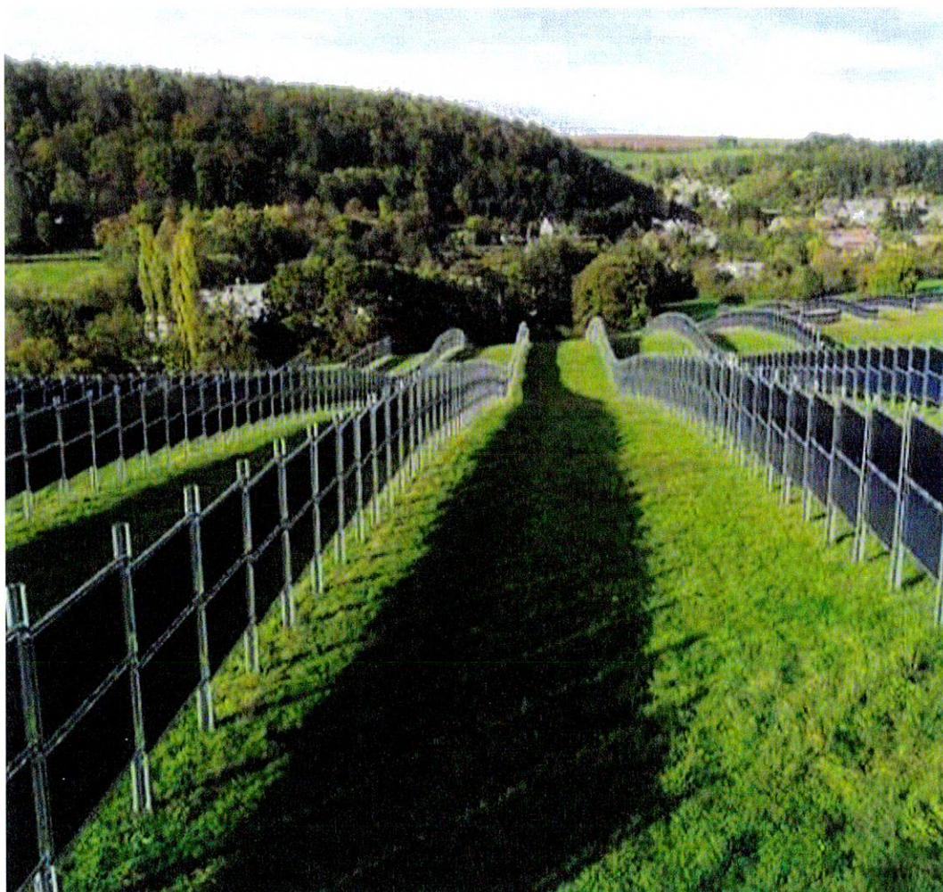
Abbildung 6: Foto einer bifacialen Freiflächenphotovoltaikanlage, Next2sun
