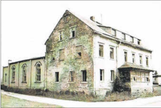
Das Bild zeigt den Zustand kurz vor dem Abriss. In den 80er-Jahren war der äußere Zustand ähnlich, nur die Fensterscheiben waren noch nahezu alle in Ordnung.
