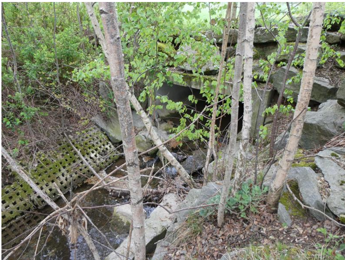
Foto 19: Goldbach-Unterführung an der Wilhelmsdorfer Str. Höhe Plangebiet, 16.04.2024.
